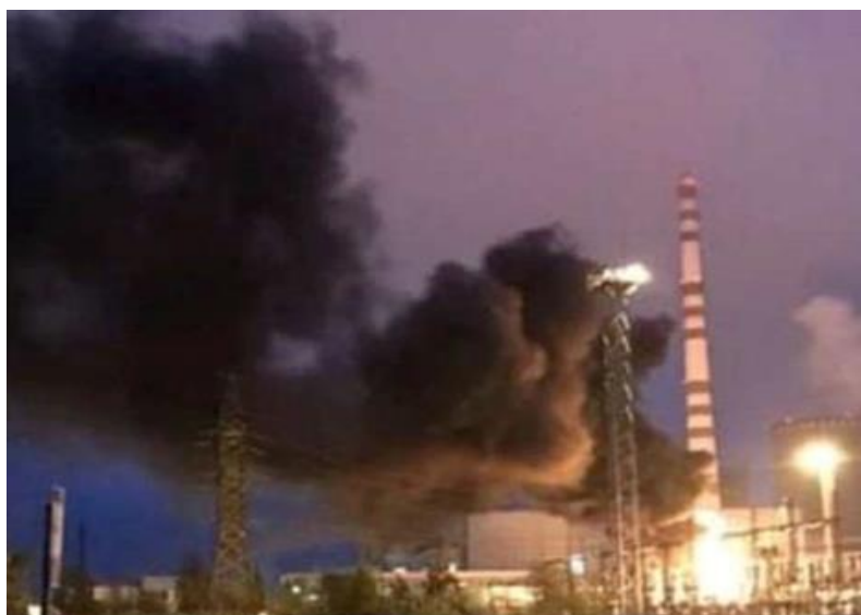
Рисунок 1.2 – Пожар трансформатора на площадке Ровенской АЭС
