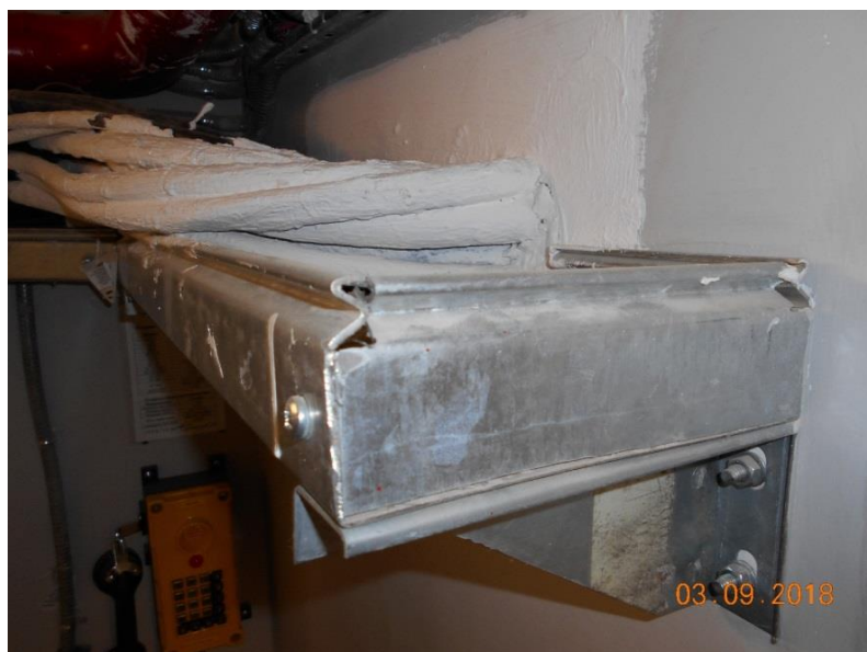
Рисунок 2.52 – Внешний вид кабелей без короба
